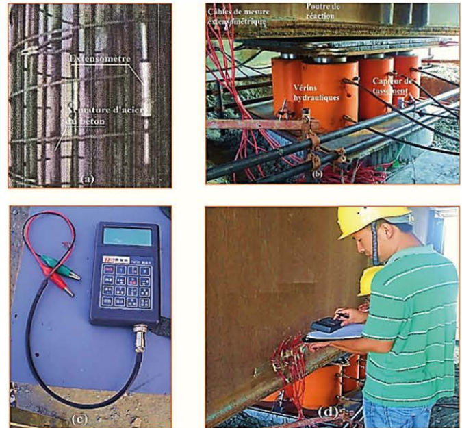
Figure 2. Photos d'instrumentation du pieu et d'acquisition de résultats d'essai
